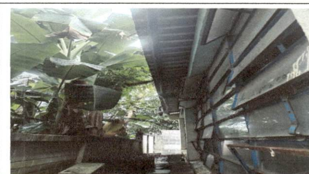
Foto 12: MODULO G AULA Se instalara canal de lamina galvanizada
