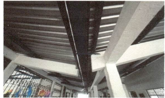
Foto 4: TRABAJOS EXTERIORES, Sutiucion de canal galvanizado
