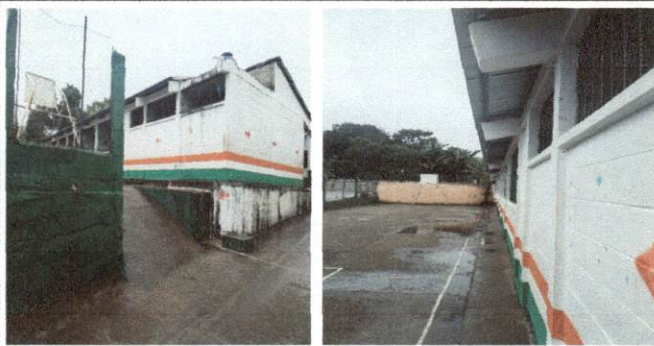
Foto 3: MODULO A AULA instalacion de canal galvanizado
